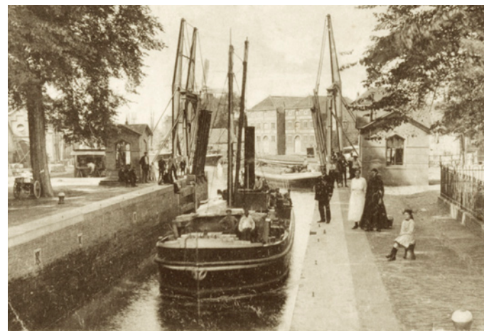
Stoomboot schut in de Mallegatsluis rond 1918.
