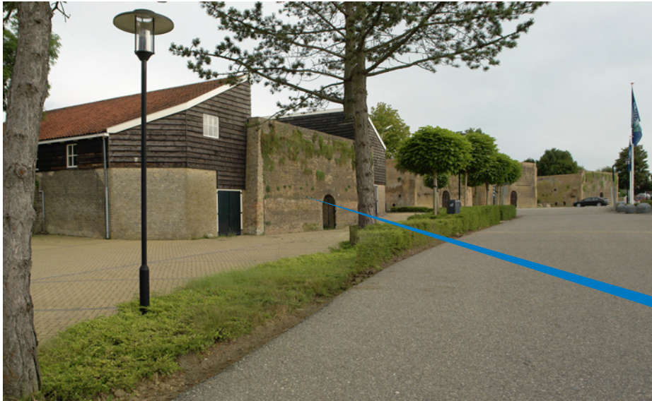
Rijksmonument Steenovens Klein Hitland. Deze fabriek sloot als laatste in 1964. De ovenrestanten werden in 1986 en 2013 gerestaureerd.
