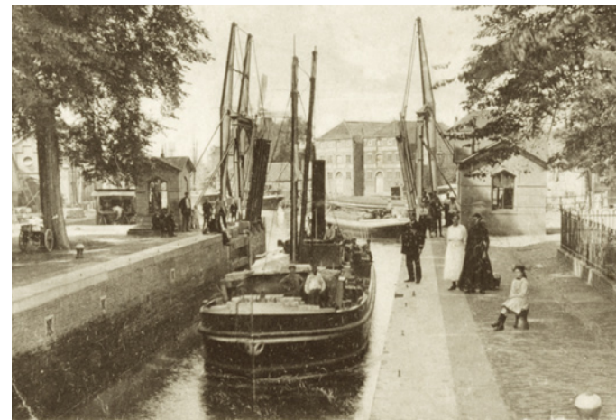
Stoomboot schut in de Mallegatsluis rond 1918.
