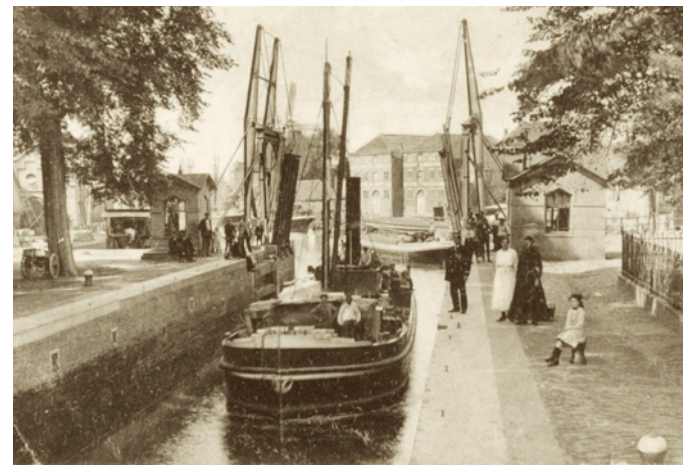
Stoomboot schut in de Mallegatsluis rond 1918.
