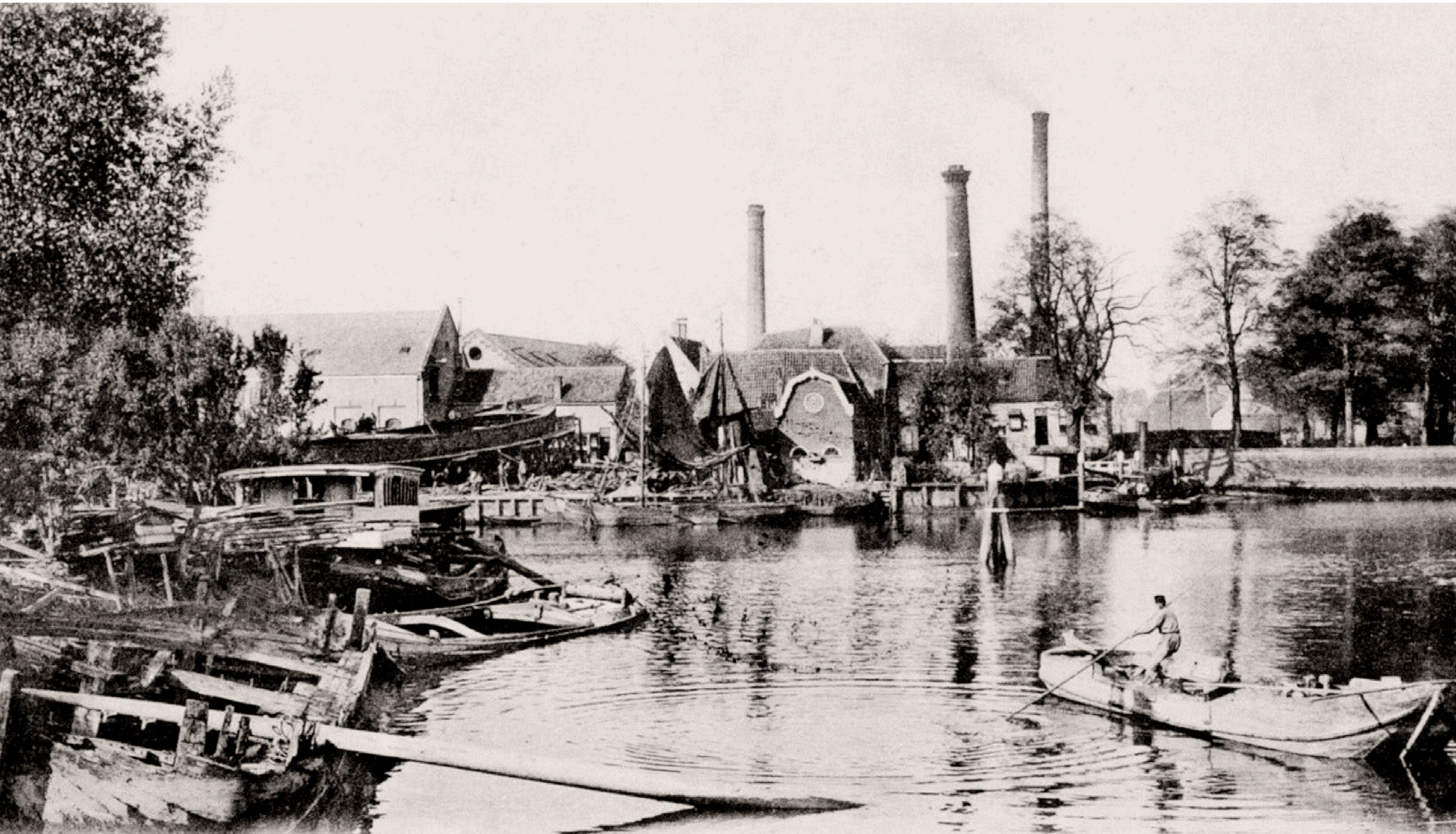
Scheepswerf in Gouda links aan de overkant. Rechts voor een baggeraar
