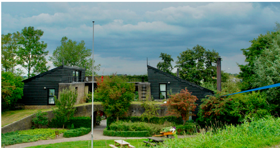
Rijksmonument Steenoven de Olifant. Deze fabriek sloot ±1918. Alleen deze oven werd gereed en verbouwd tot villa in 1972.
